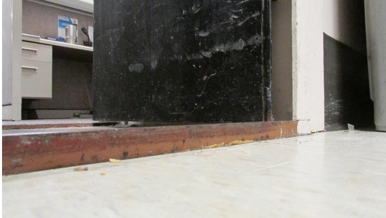
Rm 112-06 Old Safe Door Frame Trip Hazard
